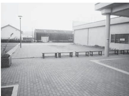
「渚の駅」たてやま商業施設棟建設予定地
