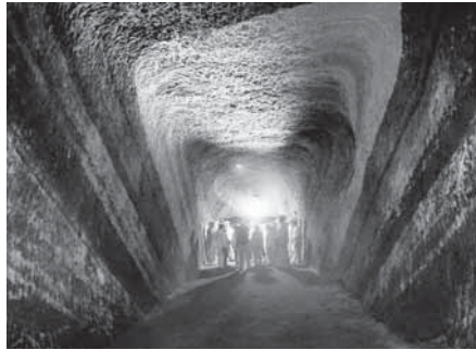
赤山地下壕の内部
