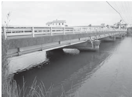
館山大橋の様子
