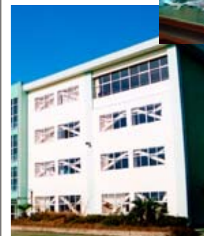
◀ T・Tルーム、学年室の窓側には、耐震補強のブレースを設置
