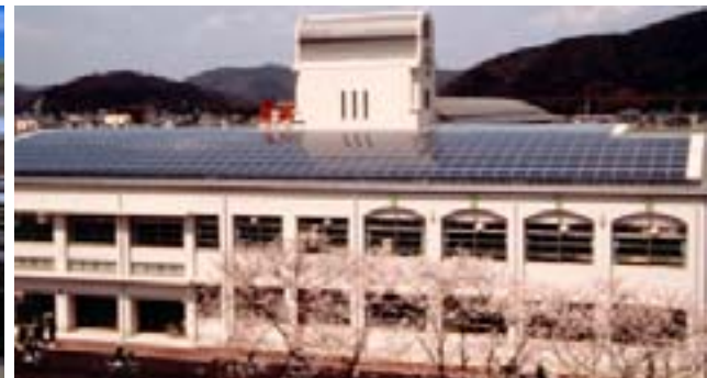
▼学校用太陽光発電（京都府八木町）
