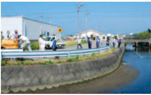
▲船形地区宇田川での作業の様子
