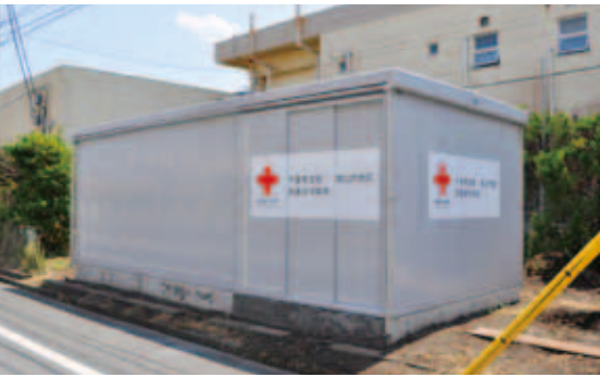
▲ 4号館裏側に設置された防災備蓄倉庫
