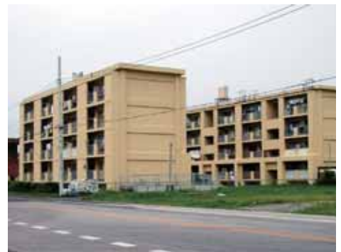
▲船形市営住宅
