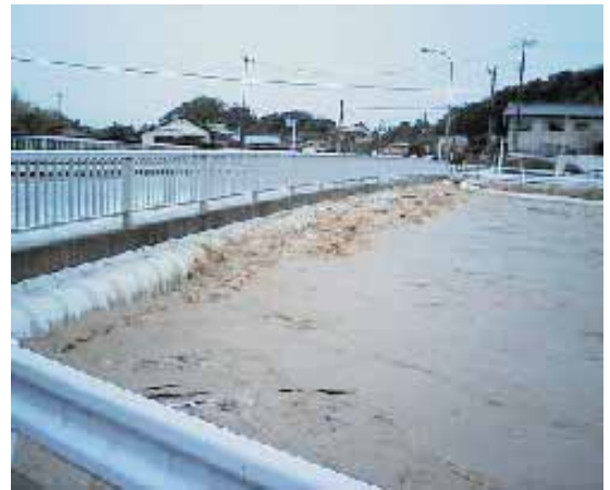
▲大雨による平久里川の増水 (平成 18 年 4 月 12 日 横峯大橋付近)
