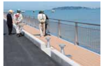
▲ウッドデッキの歩道
