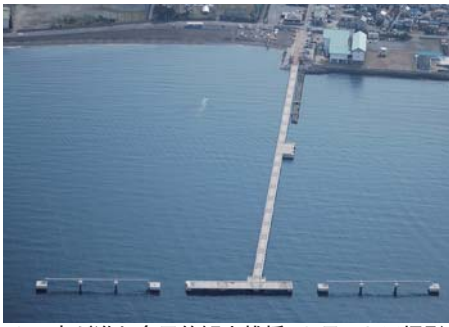
▲工事が進む多目的観光棧橋(2月19日撮影)
