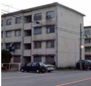
▲那古市営住宅
