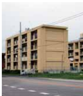
▲船形市営住宅
