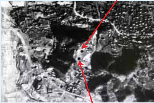
▲昭和22年の赤山周辺の航空写真。大きな2つの穴は、工事が中断された横須賀海軍軍需部館山支庫燃料タンク跡
