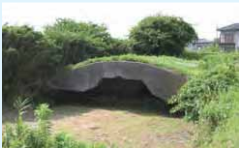
▲宮城に残る飛行機掩体跡。側壁の厚さ約70cmで、60kg爆弾の直撃に耐える構造とされる
