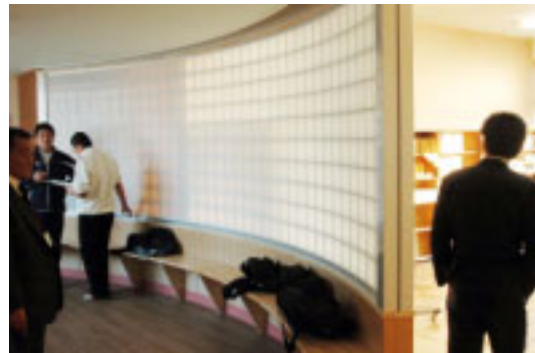
▲ガラスブロックの曲面壁とベンチコーナーを設置
