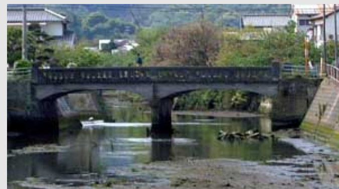
今年度工事が予定されている要橋
