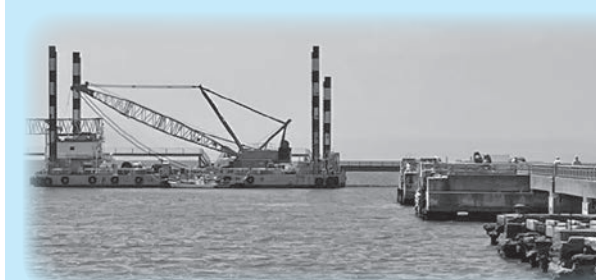
館山夕日桟橋の先端部の拡張工事（R4）
