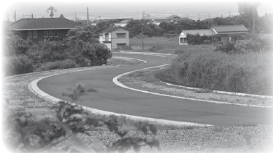
起点部約300m区間の現状
