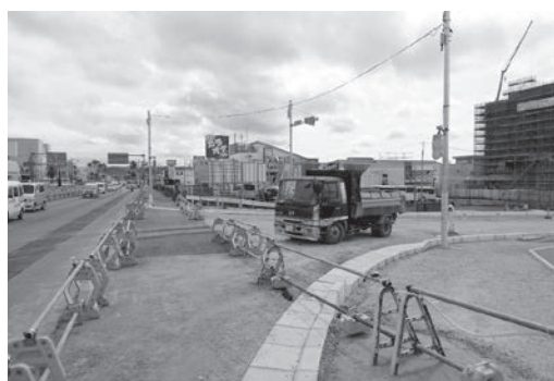
市道1277号線と国道127号の交差点（工事中）
