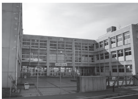
解体される旧第三中学校校舎
