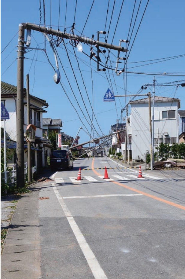
倒れた電柱（船形地区）
