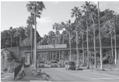
4車線化が進められる館富トンネル付近
