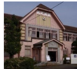
旧安房南高等学校第一校舎
