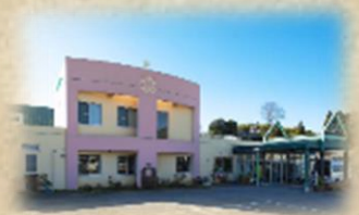
障害者支援施設 しあわせの里
