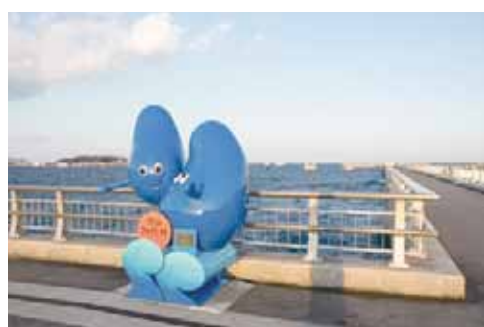
新しい物揚場が建設される館山夕日棧橋
