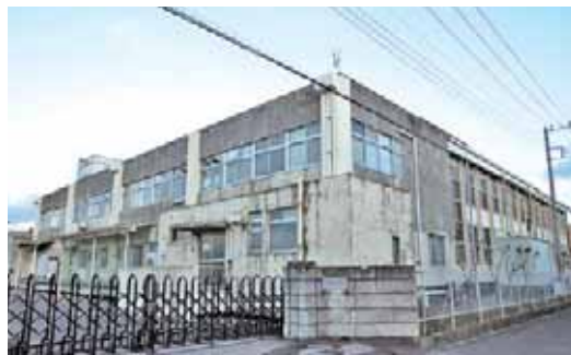
建て替えが予定されている学校給食センター
