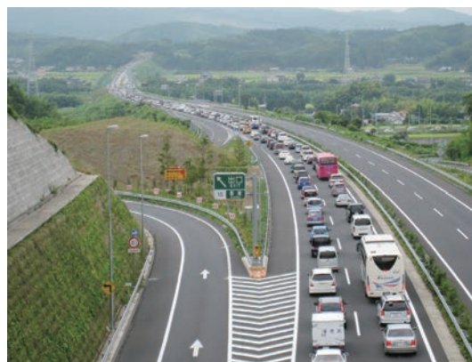
東関東自動車道館山線（君津インターチェンジ付近）
