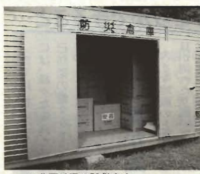
▲豊房地区の防災倉庫
