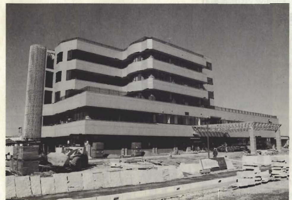
6月1日開院へ準備が進められている安房医師会新病院
