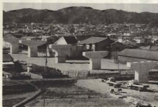
国道410号北条バイパス跨線橋
