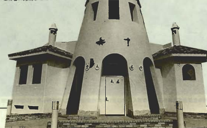
この春に完成した北条海岸トイレ
