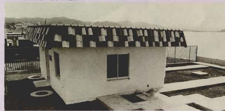
汐入川下流に完成した排水処理施設
