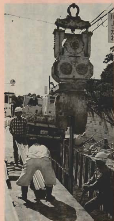
広域水道企業団による送水管布設工事 (国道128号館山分地区内)
