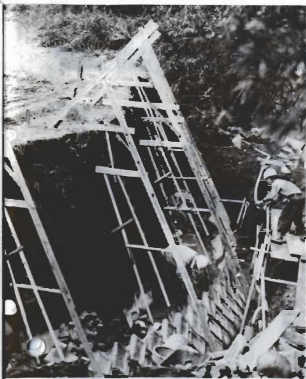
豊房地区を流れる普通河川笹川の復旧工事が急ピッチで進みます。
