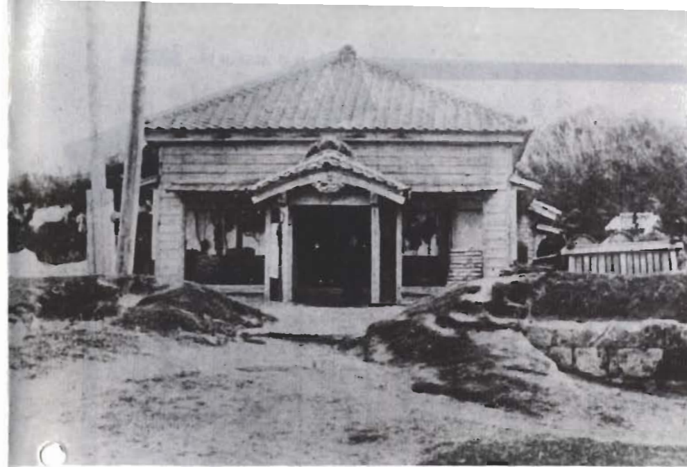
明治のころ建てられた布良救護所（ナルセ写真館提供）
