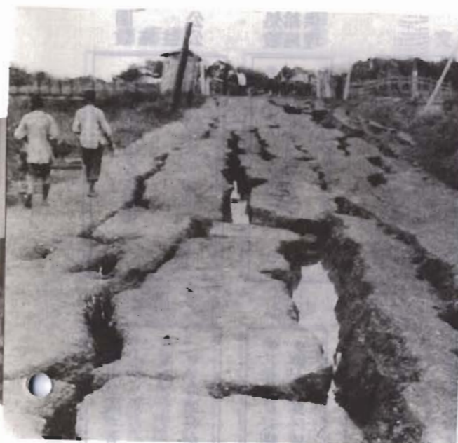
北条地区の地割れ(関東大震災)
