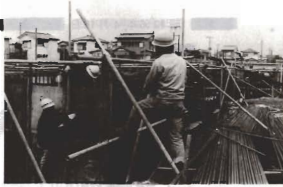
建設進む船形小学校
