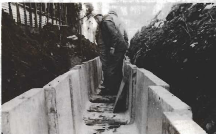
完成間近な長須賀八町内の水路の改良工事
