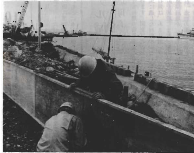
盛漁期を前に進む船形漁港工事
