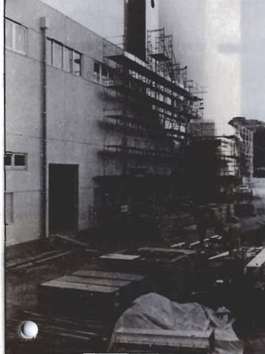
衛生センターの工事も順調
