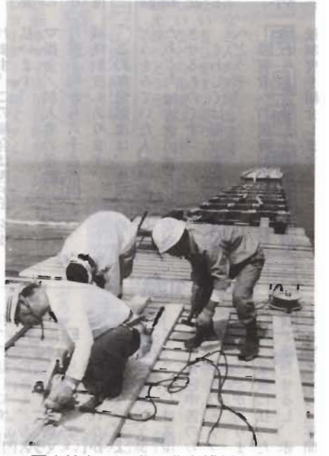
夏を控えて、進む北条棧橋の工事
