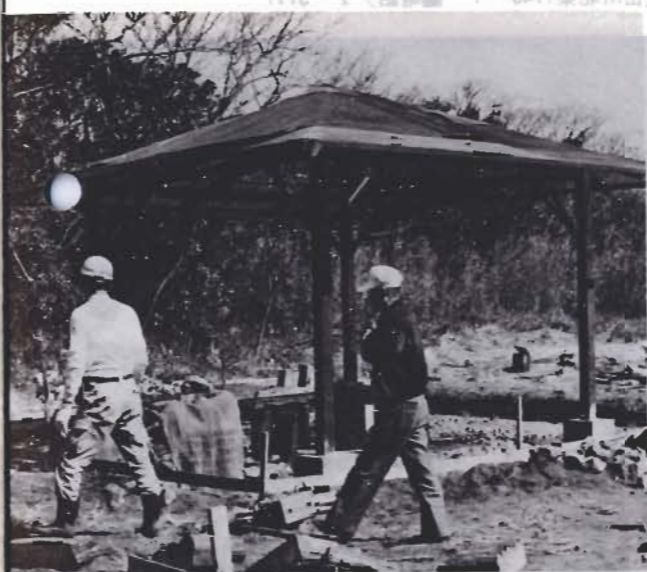
沖の島に建設中のあずま屋。自然木に似たコンクリートをつけ、周囲の風景と、つり合うものにします
