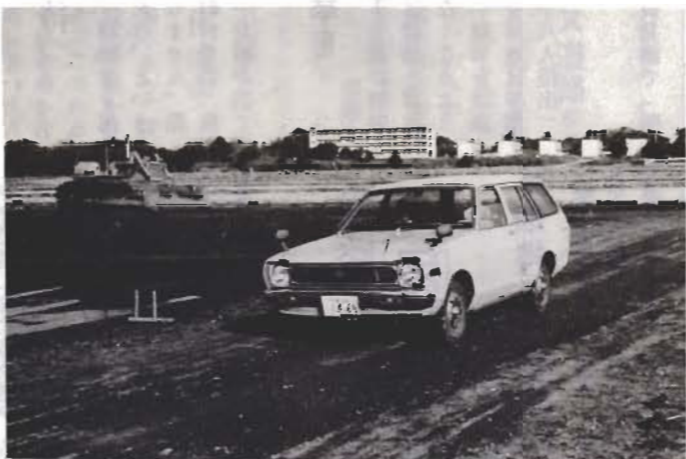
ほ場整備地域内の道路も完成間近
