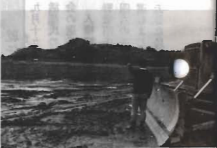
着工を待つだけの建設予定地
