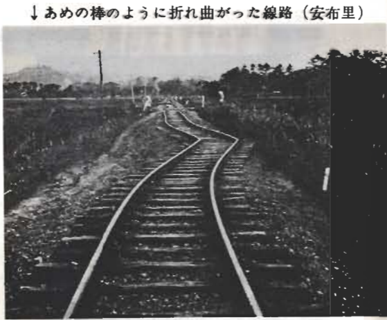
↓ あめの棒のように折れ曲がった線路 (安布里)
