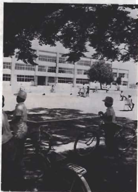
第3期工事が始まった館山小防音校舎
