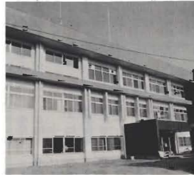
← 建築中だった館山警察署の新しい建物が、今までの庁舎の裏に完成。鉄筋三階建ての近代的な装いで、一・二階にカウシタもできました。
