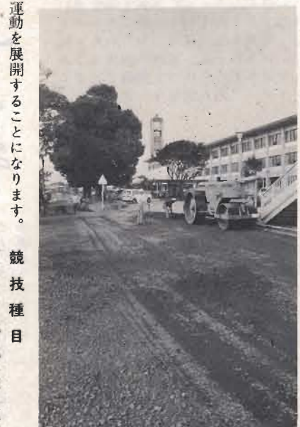
↑国体関連の道路舗装(市役所前)
