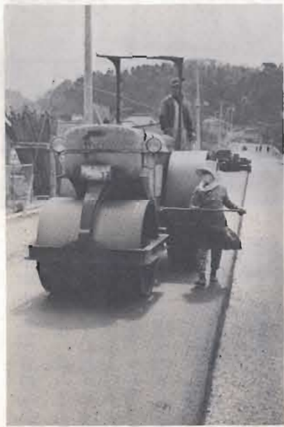
◆着々進む市道の舗装
