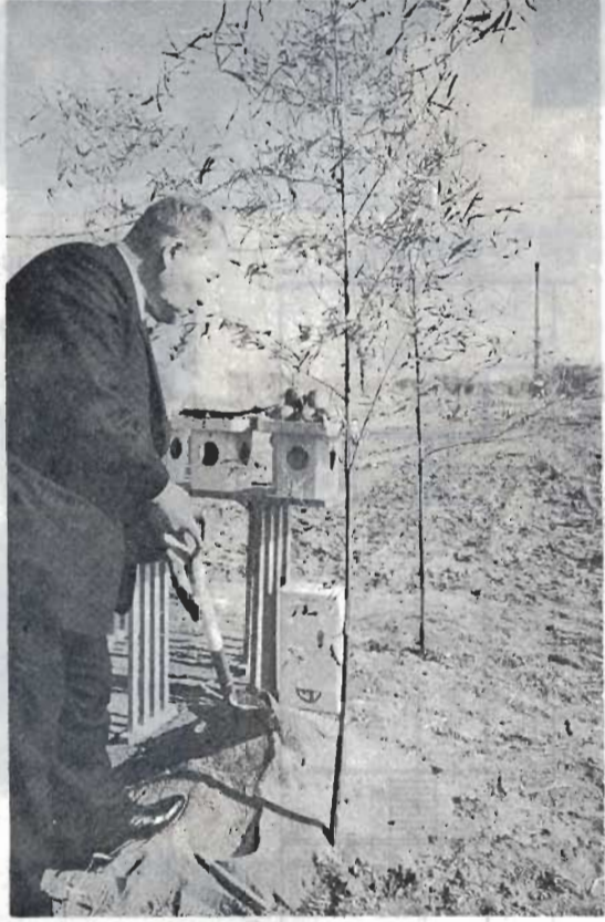
湊住宅団地起工式にくわを入れる本間市長 (エントツはゴミ処理場)
