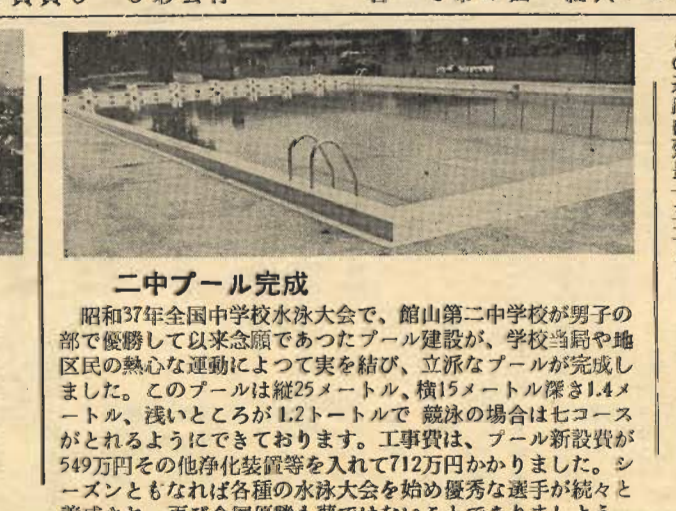
二中プール完成
