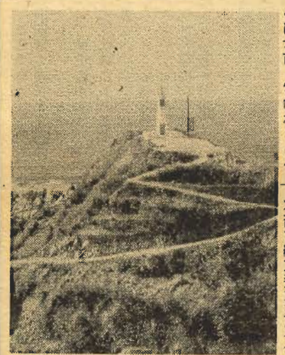
布良鼻燈台の竣工 北緯三四度五分三〇秒 東經一三九度四九分三 八、〇秒 二、等級及び燈質 明暗白光、明三秒、暗 三秒 三、光達距離 二〇・〇海里 四、燈高 平均水面上から燈火中 心まで、五六・〇〇米 (寫眞は布良鼻燈台)
