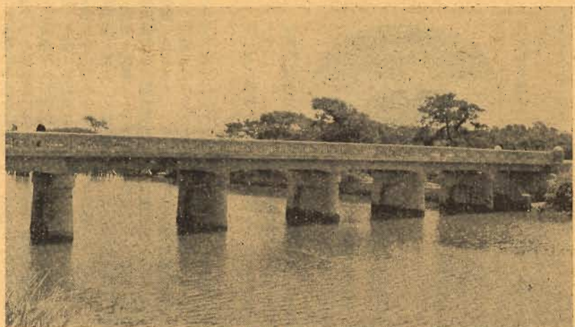
(完成された湊橋)
