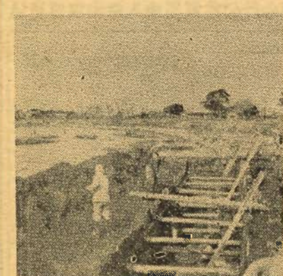
(汐入川災害復旧工事)
